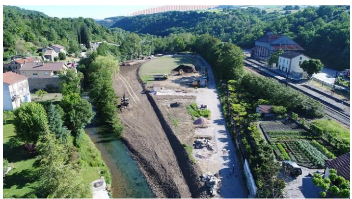
Restauration de l'espace Jean GAVEN à St-Rome-de-Cernon
