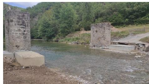
Les travaux de démolition de l'ouvrage ont commencé fin août. De nouvelles fondations et un tablier fer et béton ont été créés de manière à favoriser la circulation piscicole en-dessous de l'ouvrage et limiter la formation d'embâcles.
