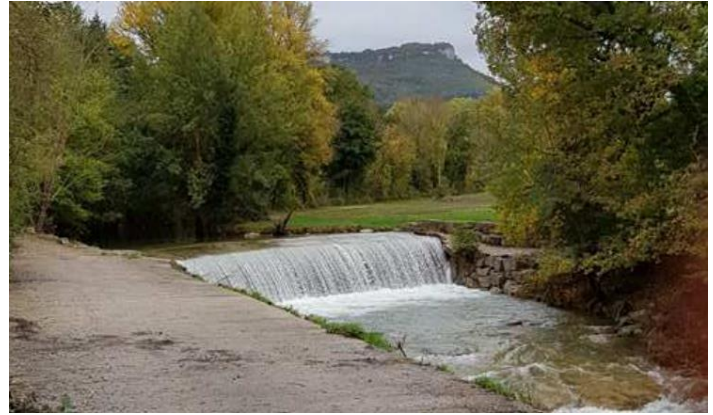
Seuil « Haut » / Chaussée / Cascade de l'ancien moulin de Palliès
