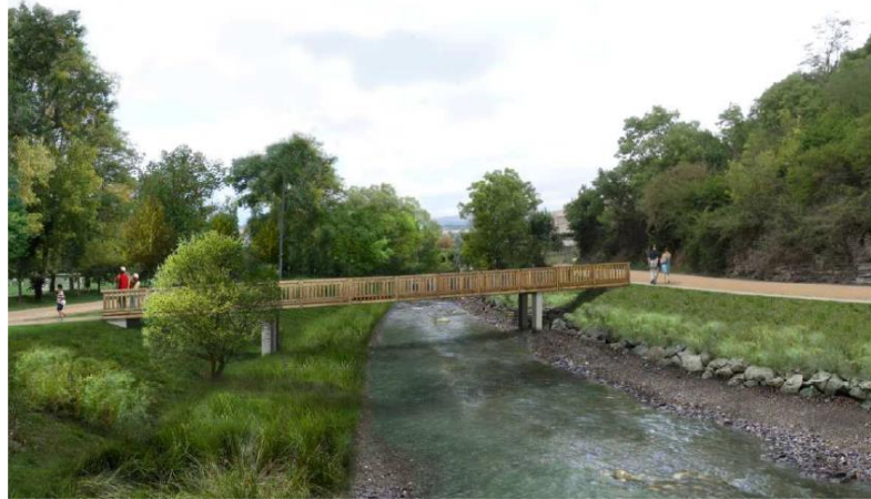
Illustration du rendu attendu des travaux après l'effacement du seuil et la valorisation des cheminements piétons connectés par la pose d'une passerelle piétonne, ©EGIS eau-2020
