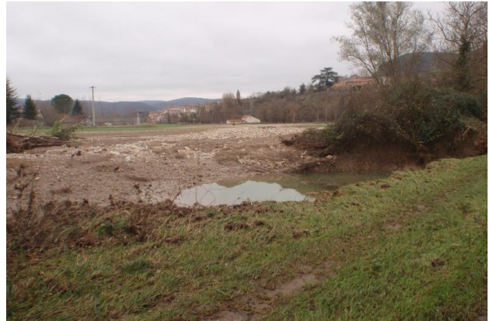
Rupture du merlon en novembre 2014 (vue vers l'aval)
