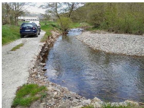
La Jonte à Salvinsac avant et après travaux
