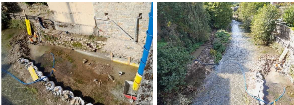
Accompagnement de travaux de réparation d'un mur de soutènement sur la Jonte au Rozier en septembre 2025.
