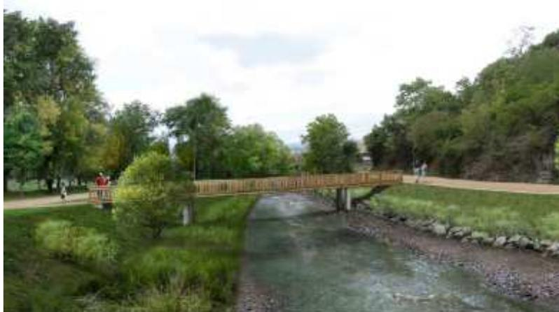
*Illustration du rendu attendu des travaux après l'effacement du seuil et la valorisation des cheminements piétons connectés par la pose d'une passerelle piétonne.*
